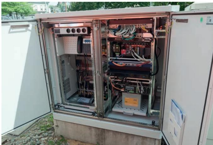
**Bild 7: BLS-Außenschrank zur Anbindung der Bahnsteigausrüstung**
